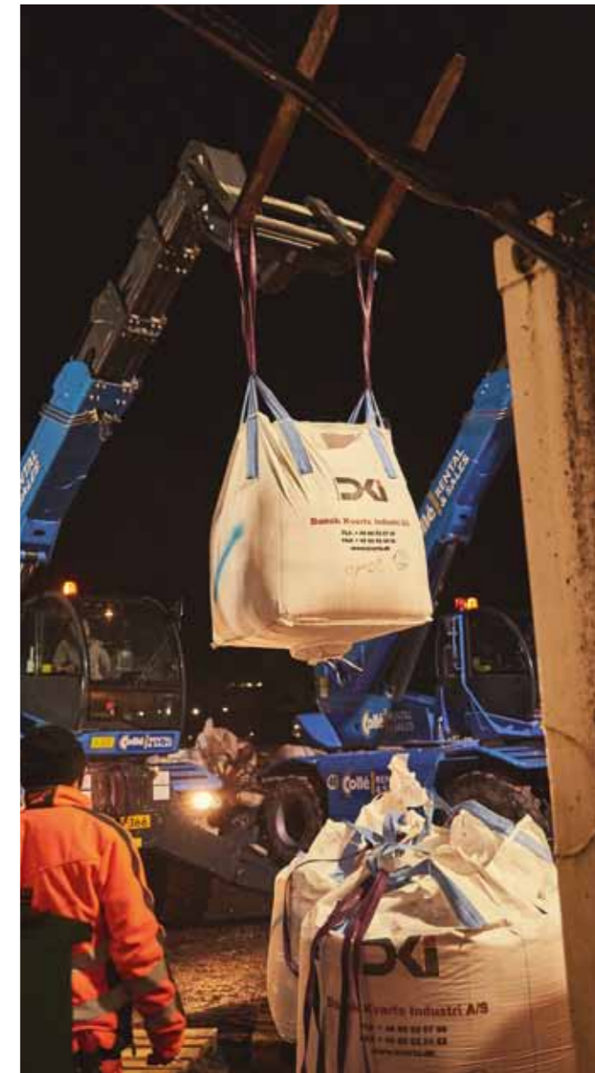
Rechts: In sogenannten Big Bags wird Gesteinskörnung aufbewahrt und transportiert
